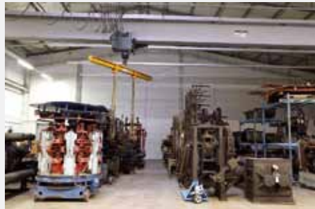
Schwerlastfläche mit Hallenkran
