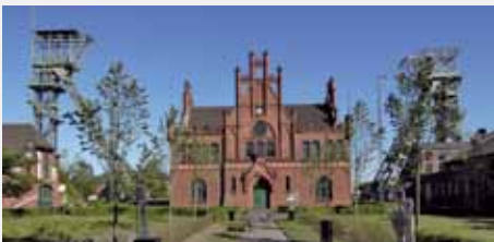
Blick in den Ehrenhof der Zeche Zollern mit der Alten Verwaltung
